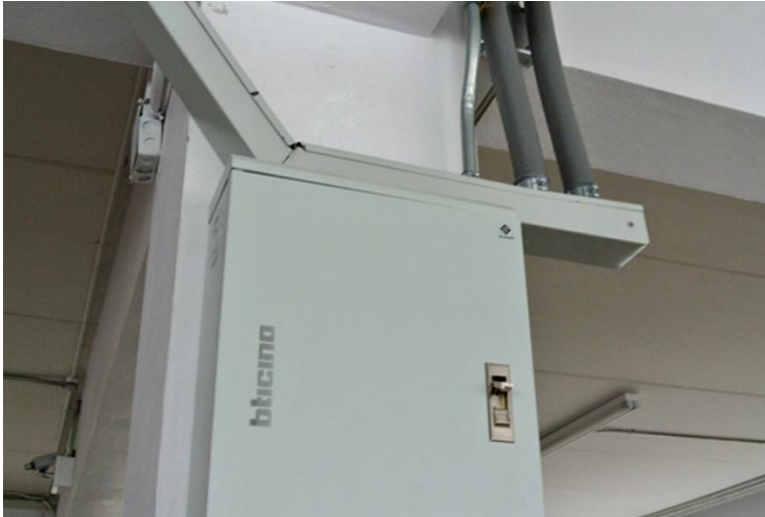
ติดตั้งตู้ไฟฟ้าย่อย
