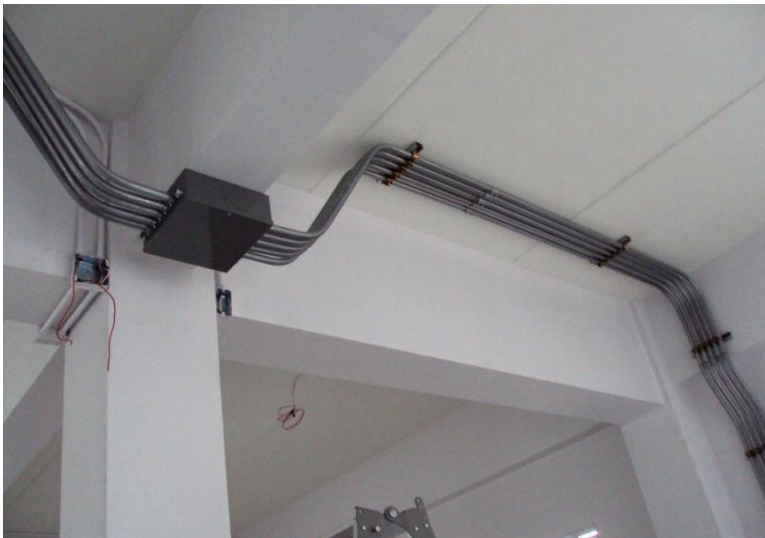
ติดตั้งเดินท่อร้อยสาย-เดินรางสายไฟ
