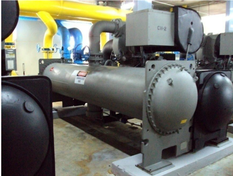
ติดตั้งระบบแอร์ Chiller
