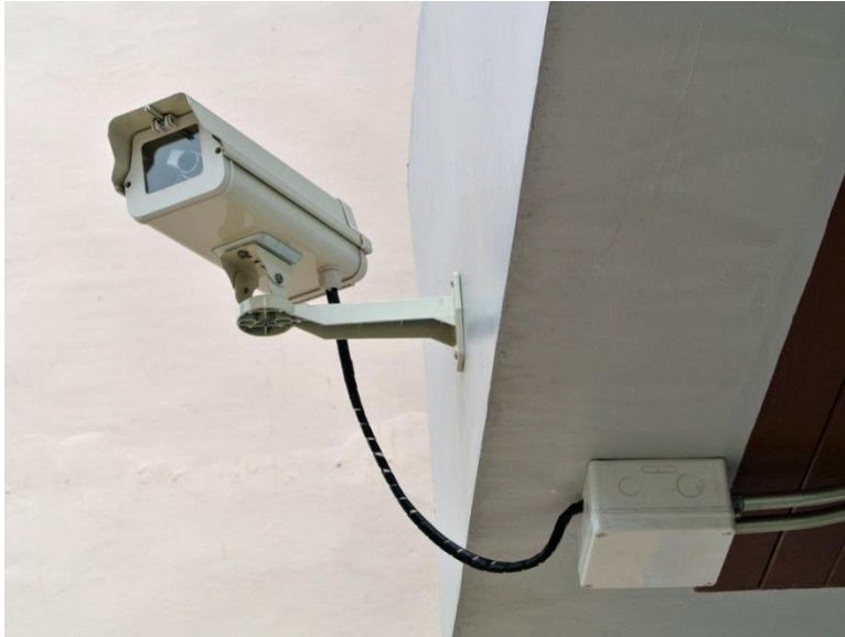
งานติดตั้งระบบกล้องวงจรปิด (CCTV)
