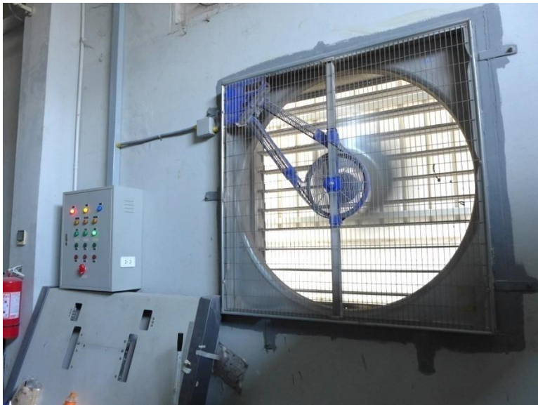
ติดตั้งระบบระบายอากาศภายในโรงงาน
