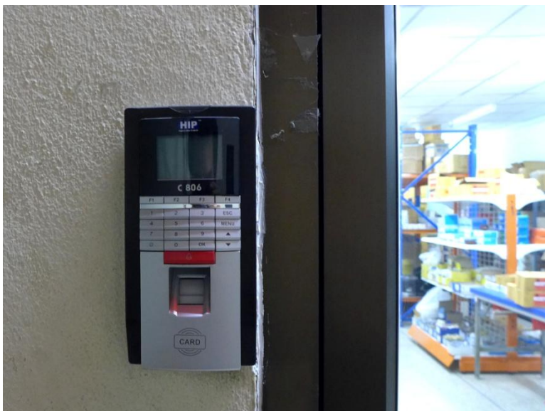
ติดตั้งเครื่อง Access Point ผ่านเข้า-ออกด้วยการ สแกนลายนิ้วมือ และเดินสายซ่อนภายในผนัง
